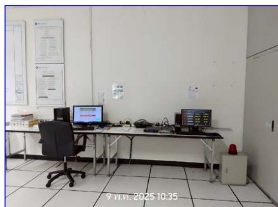
รูปที่ 2.3 เครื่องวิเคราะห์และแสดงผลคุณภาพอากาศจาก CEMS
