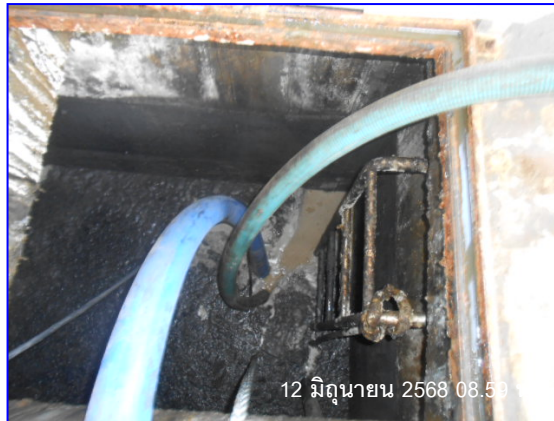
รูปที่ 2.31 บ่อพักน้ำชะมูลฝอย
