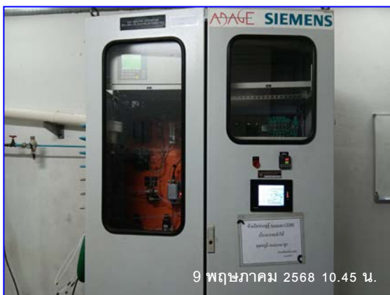
รูปที่ 2.3 เครื่องวิเคราะห์และแสดงผลคุณภาพอากาศจาก CEMS
