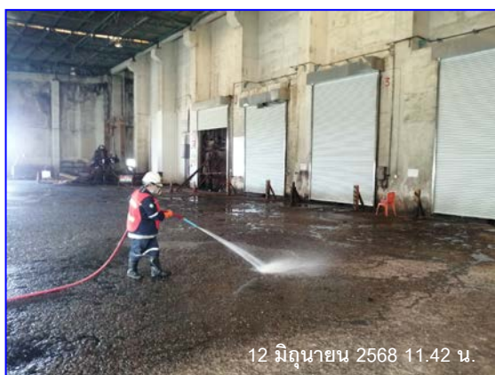
รูปที่ 2.41 ฉีดล้างทำความสะอาดลานเท เพื่อป้องกันฝุ่นละออง
